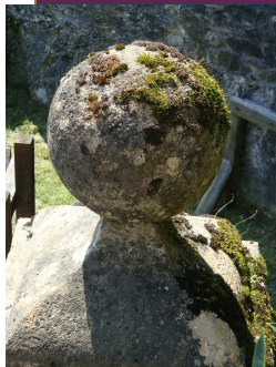
Colonisation de la pierre par les mousses et les lichens Château de Bouillon Belgique
