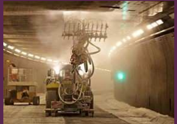
Photo 1 : Application de la solution crémeuse sur le plafond du tunnel
